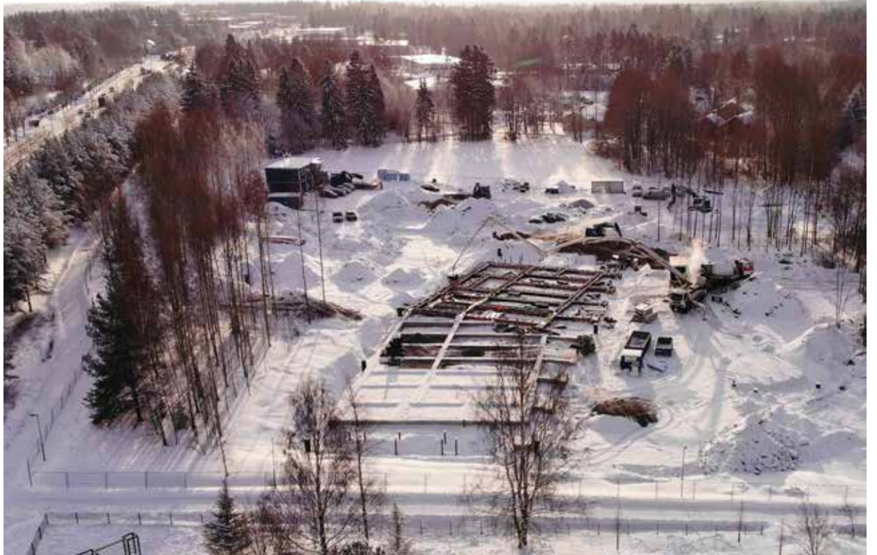
Päiväkoti rakennusvaiheessa. Kuva: Mikko Metso / Aikatallennus Oy
